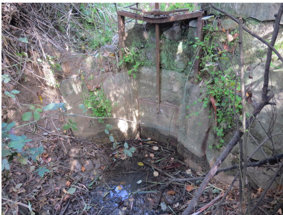
Fig. 9. Compuerta de la acequia Honda.
