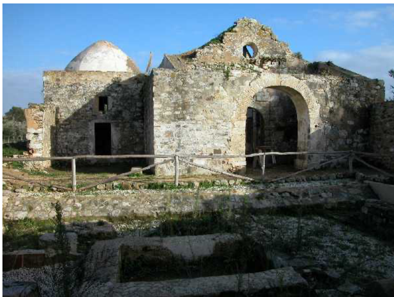
Figura 2.- Edificio religioso de la Ermita de San Ambrosio
